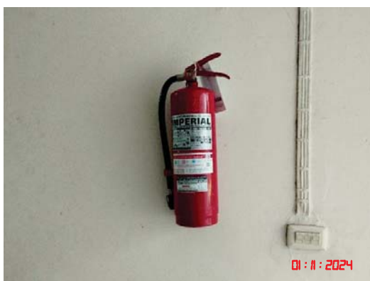
ถังดับเพลิงเคมีแบบมือ
